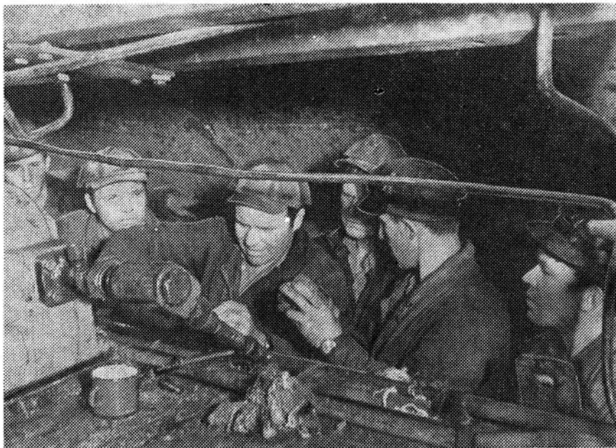
М. Савельев (в центре) среди слесарей-монтажников СМУ-11
