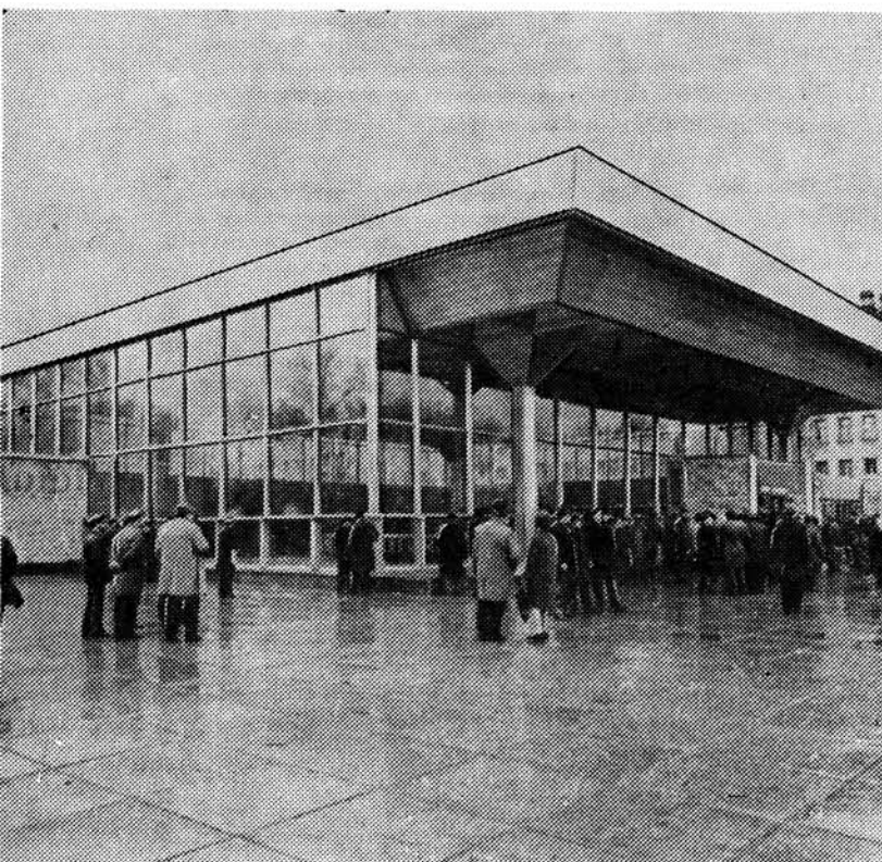
Вестибюль станции «Выборгская»
