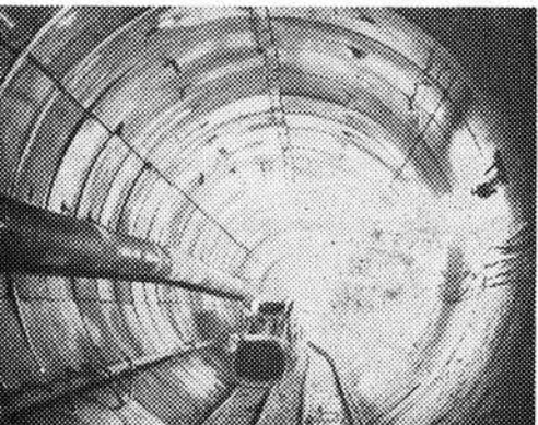
Перегонный тоннель в сторону станции «Киевлян»
