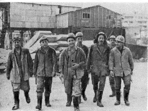
Закончила смену бригада проходчиков П. Сергеева, сооружающая станцию «Киевлян»
